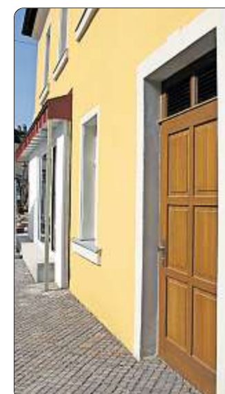
In der Breiten Straße befinden sich die Eingänge zu VHS, Großtagespflege und Café-Treff. Der Haupteingang zum MGH wird gerade am Gabelmannsplatz fertig gestellt.
